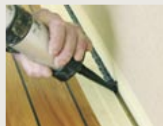
6 - Appliquer un joint périphérique NAVYJOINT puis le lisser
