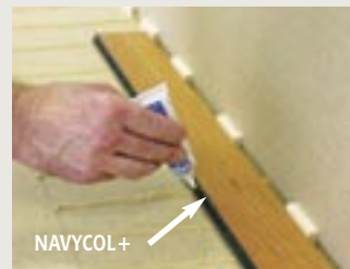
2 - Encollage des languettes avec NAVYCOL+
